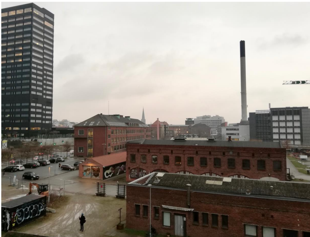
Midtkraftgrunden set fra kulbroen. På billedet ses de ovennævnte bygninger. Foto: 2019, Larsen og Nordstrøm
