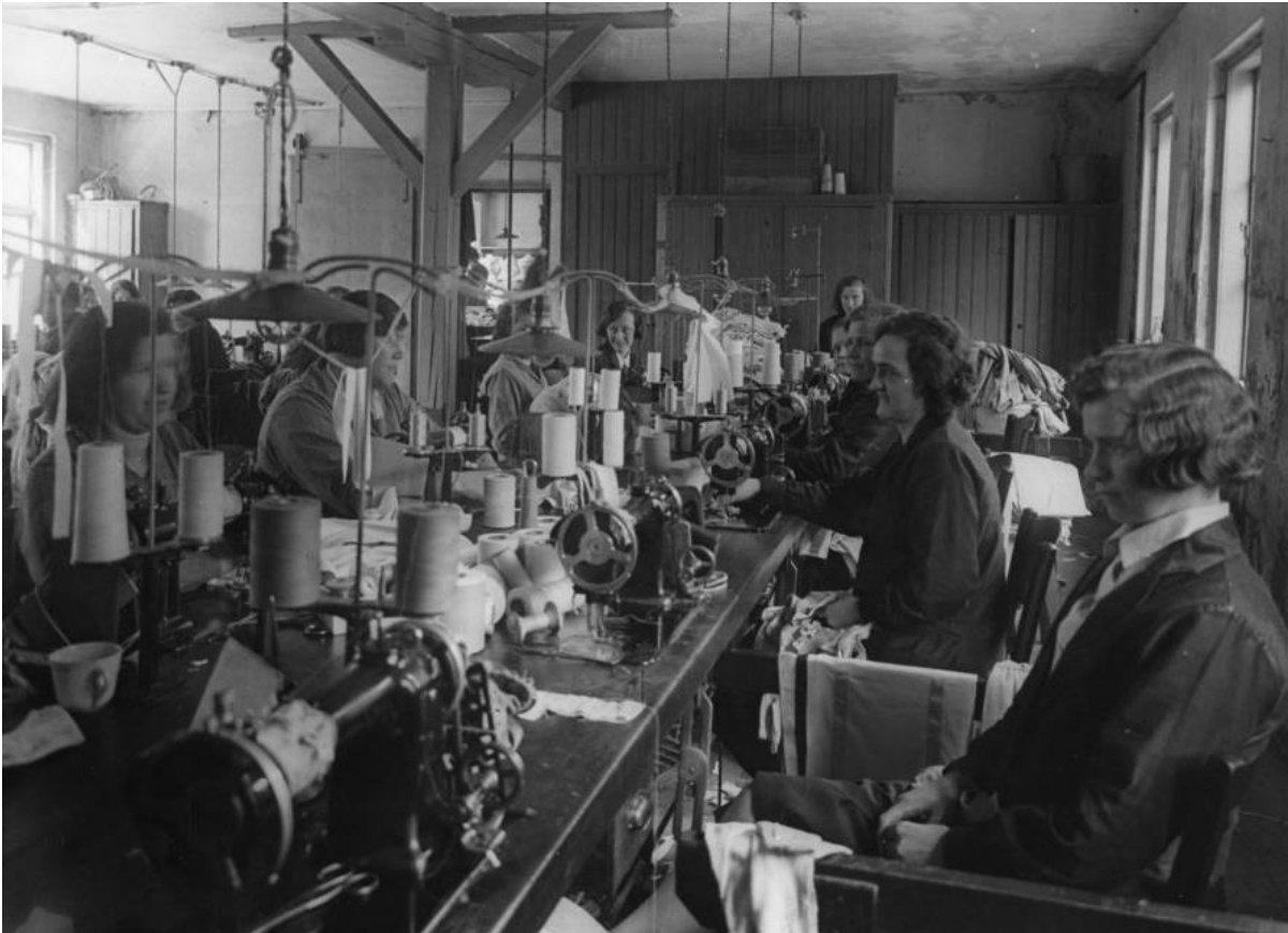
Syersker på Trikotagefabrikken i Rosensgade 14-20 før fabrikken flyttede ud til Silkeborgvej i 1931. Her ses det lange bord i midten af lokalet med syerskerne omkring, og man får en fornemmelse af, hvor mørkt lokalet har været, og hvor sammenpresset syerskerne sad. Fra Aarhusbilleder.dk
